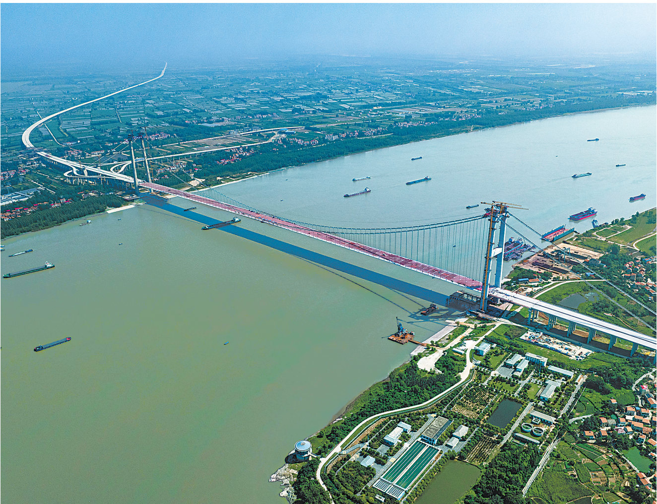
7月26日，双柳长江大桥实现精准合龙。双柳长江大桥是目前长江上在建的最宽钢箱梁悬索桥。
