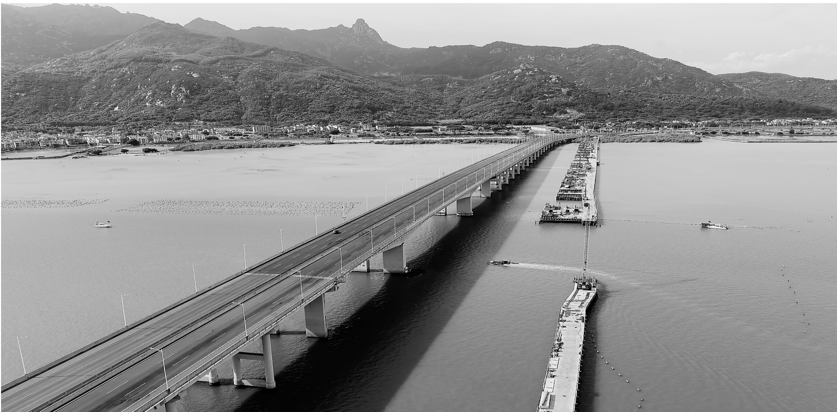
7月18日,新建漳州至汕头高铁全线控制性工程漳江湾跨海特大桥主栈桥完工,为后续海上各工作面施工奠定基础。漳汕头漳江湾跨海特大桥桥梁全长5.8公里,海域部分桥梁长5公里。目前,大桥主体结构施工正在有序推进。新华社发
