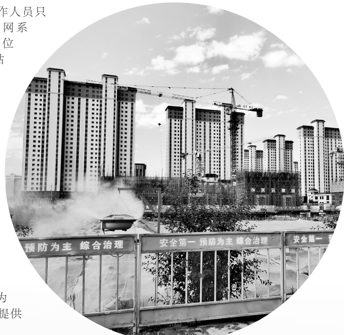
凉州区建筑工地采用负离子雾化盘进行降尘作业。新甘肃·甘肃日报记者 顾丽娟
