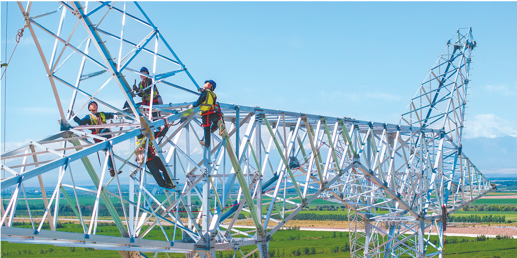
盛夏,张掖电厂扩建煤电七百五十千伏送出工程线路施工现场,国网张掖供电公司员工冒着高温进行铁塔组立作业。
