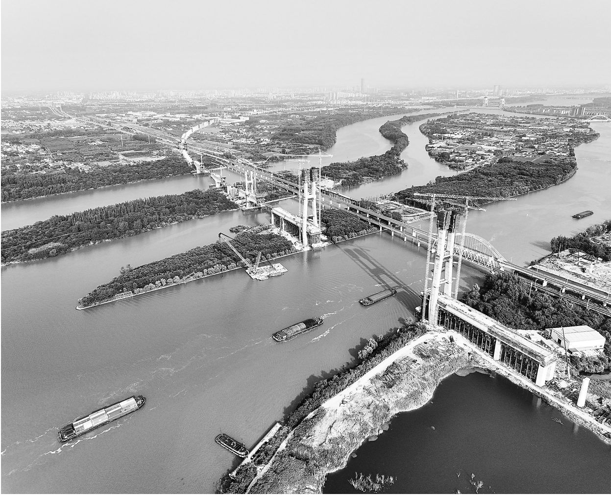
这是沪渝蓉高铁跨京杭运河斜拉桥施工现场(7月13日摄)。近日,沪渝蓉高铁跨京杭运河斜拉桥主桥两岸钢混段架设顺利完成,大桥主桥上部结构施工转入钢梁悬臂拼装阶段,主塔建设已完成90%。
