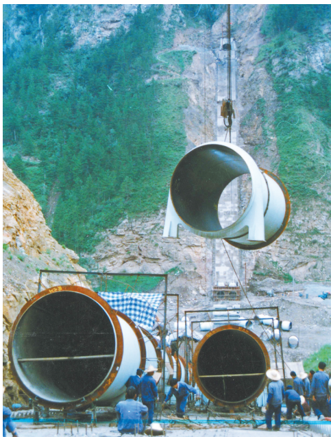
这是在引大入秦工程总干渠建设过程中,先明峡倒虹吸钢管吊装作业时的场景。(资料图)
