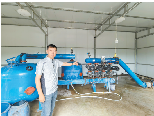
甘肃农垦条山农场兰州新区基地的水肥一体化加压泵房。 新甘肃·甘肃日报记者 王朝霞
