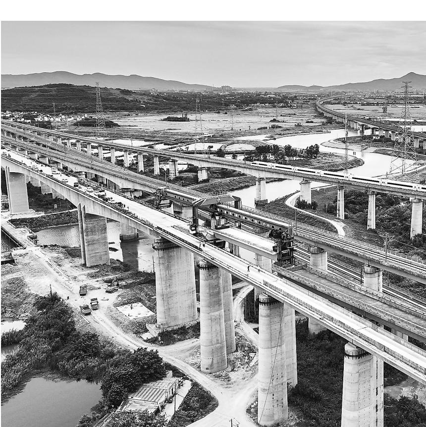
7月8日拍摄的中铁四局施工机械在巢马城际铁路最后一榀箱梁架设现场作业。巢马城际铁路是国家“八纵八横”高铁网沪汉蓉快速通道合肥至上海间的重要组成部分，设计时速350公里。
