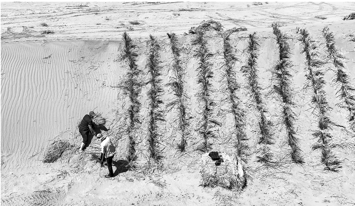
7月4日,在全塔至大墩门公路沿线“三北”工程防沙治沙项目现场,工人正在将稻草压入沙中制成草方格沙障,一排排整齐的草方格逐渐在沙地上蔓延开来,宛如一张巨大的防护网,将流动的沙丘牢牢锁住。
