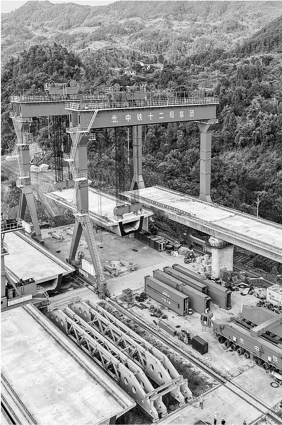
近日，渝万高铁江林村特大桥架梁施工作业现场，工人操作架梁机械在架设预制箱梁。
