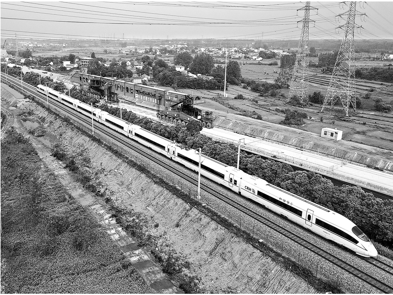
6月25日凌晨,随着最后一根重达930吨的40米箱梁架设完成,由中国铁建大桥局承建的新建上海至南京至合肥高速铁路安徽段站前四标517根箱梁架设全部完成,为后续无砟轨道施工奠定基础。
