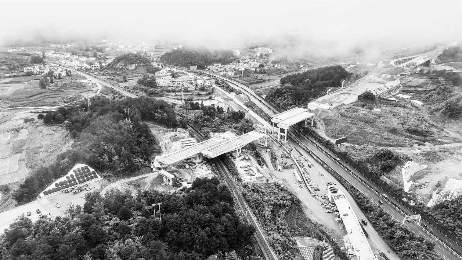
这是6月24日拍摄的贵州乌长高速公路高坝大桥转体现场。当日,由中铁二十局承建的贵州省贵阳市乌当至长顺高速公路高坝大桥成功转体。高坝大桥是乌长高速全线重点工程,桥面全长331米,转体段梁体单幅长90米、重达4000吨。大桥跨越川黔铁路、兰海高速公路及210国道,顺利完成62.1度转体。
