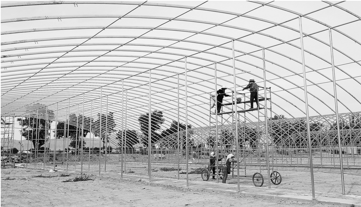
近日,工人在张掖市甘州区上泰镇“上品臻蔬”设施蔬菜产业基地搭建钢架拱棚。
