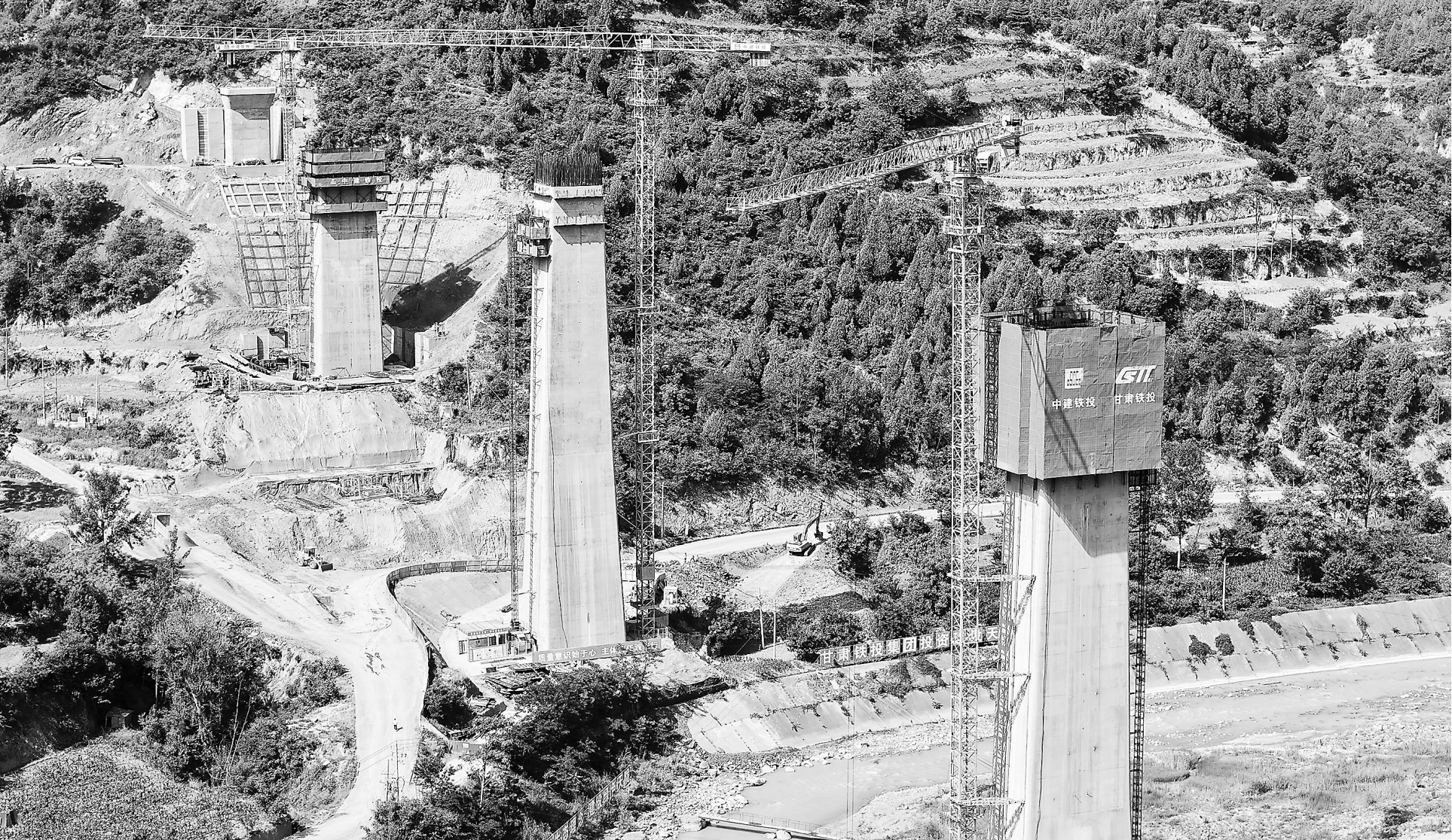
近日，由中建铁投集团承建的天院铁路太石西汉水特大桥施工现场，工人正在加紧施工。西汉水特大桥位于陇南市康县太石乡、成县黄陈镇，全长647.9米，其中3号墩高达97.78米，为天院铁路全线最高墩。
