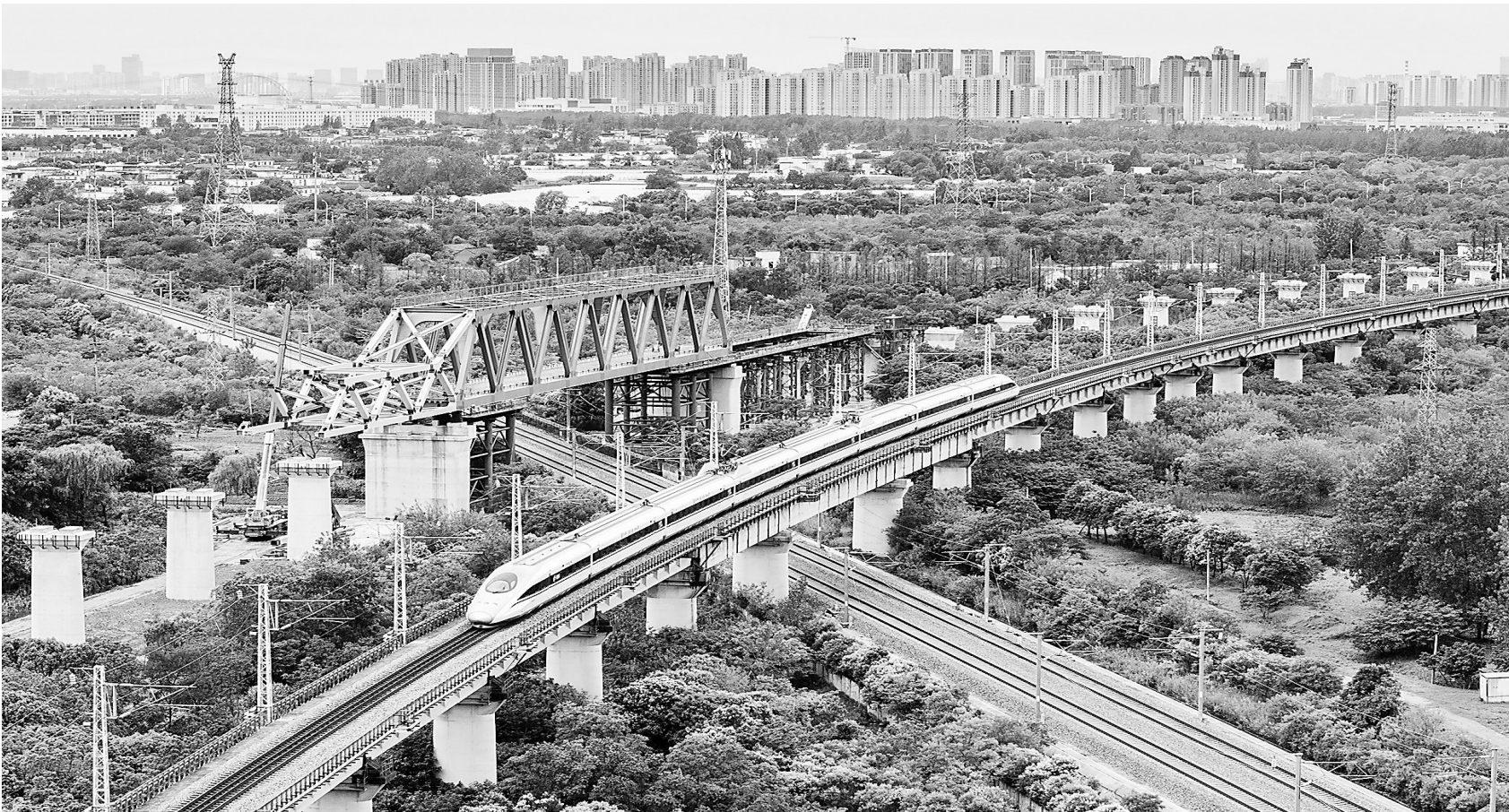
6月15日凌晨,由中铁四局承建的新建上海至南京至合肥高铁重达近千吨的钢桁梁成功跨越沪蓉铁路,为后续架梁施工奠定基础。该项目是国家中长期铁路网规划“八纵八横”中沿江通道的重要组成部分,是江北沿江城市与南京都市圈、上海都市圈快速直达的快捷通道。 新华社发
