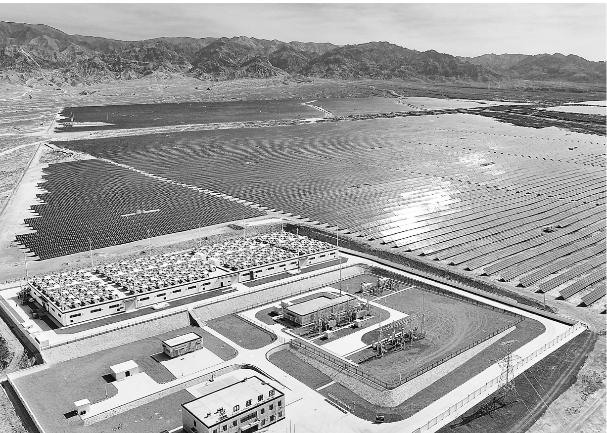
近日,在山丹县东乐北滩百万千瓦级光伏发电基地50MW/200MWH中帛源全钒液流储能项目现场,一排排大型“充电宝”矗立在光伏阵列中,为电网稳定运行提供保障。
