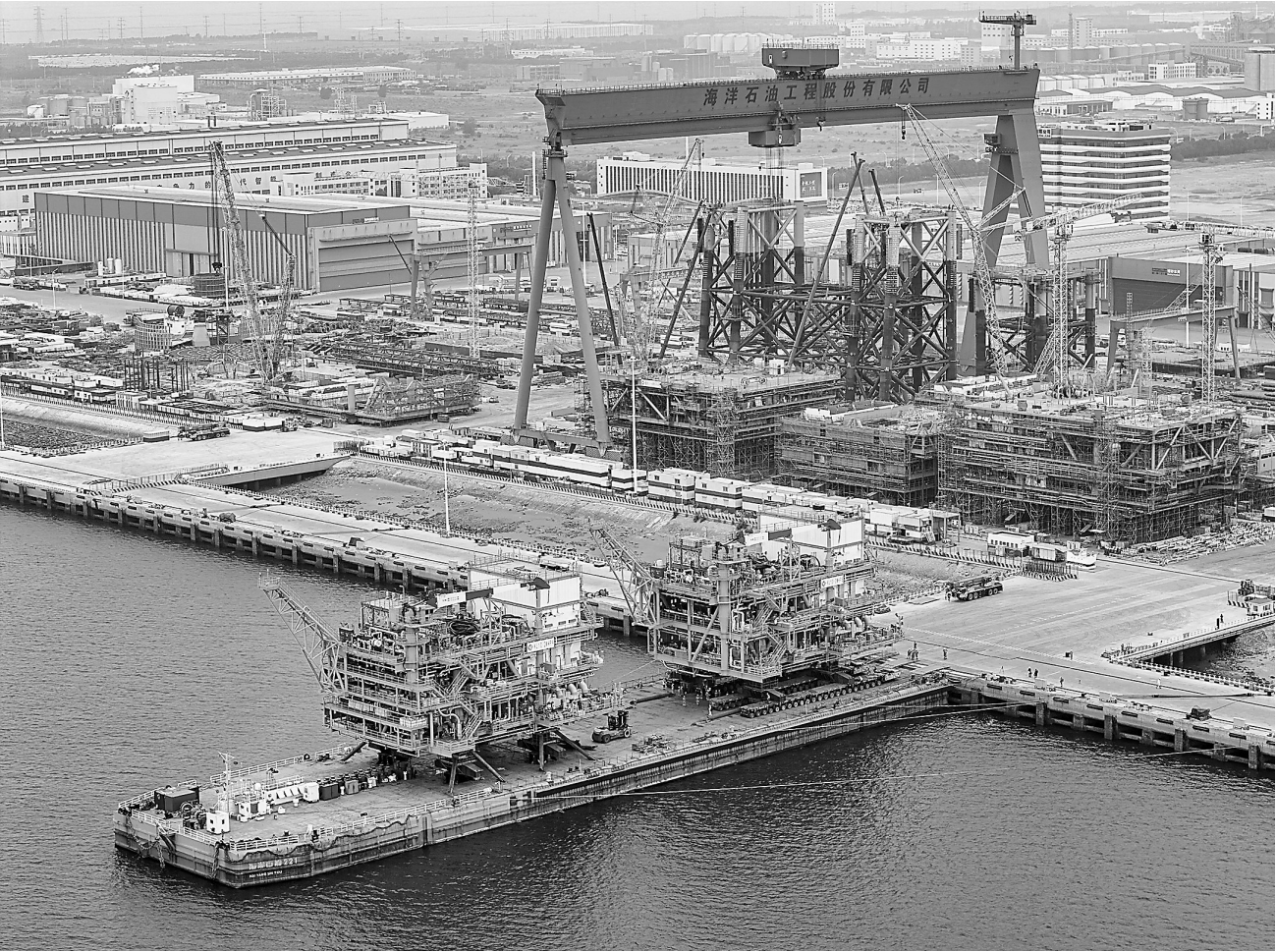
这是6月1日在天津滨海新区拍摄的垦利10—2油田开发项目（一期）平台装船作业现场。当日，垦利10—2油田开发项目（一期）最后一个平台组块在天津装船，将赴渤海南部海域进入海上安装和联调阶段。这标志着该项目3座海上平台陆地建造工作全面收官。
