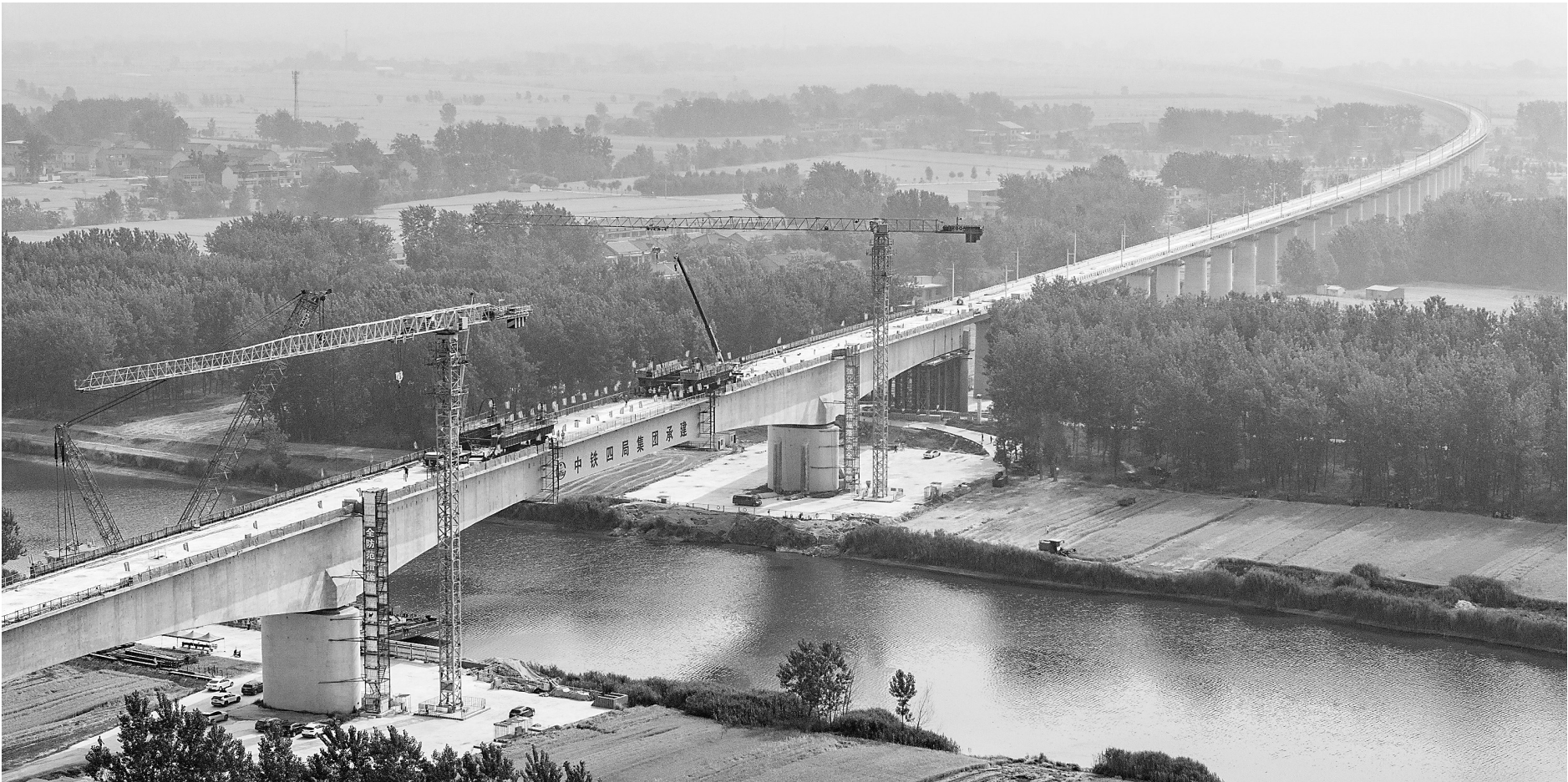
5月29日,由中铁四局承建的阜淮铁路跨涡河特大桥最后一节重880吨的钢箱梁成功完成吊装,标志着阜淮铁路跨涡河特大桥合龙。阜淮铁路位于安徽省北部,途经阜阳、亳州、宿州、淮北,正线全长约142.5公里,设计时速350公里。这是合龙后的中铁四局阜淮铁路跨涡河特大桥。
