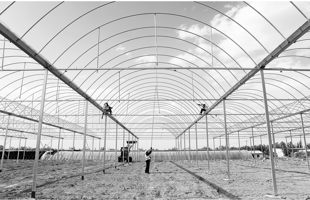
近日,在嘉峪关市新城镇新城村戈壁农业产业园里,工人正在搭建钢架大棚。
