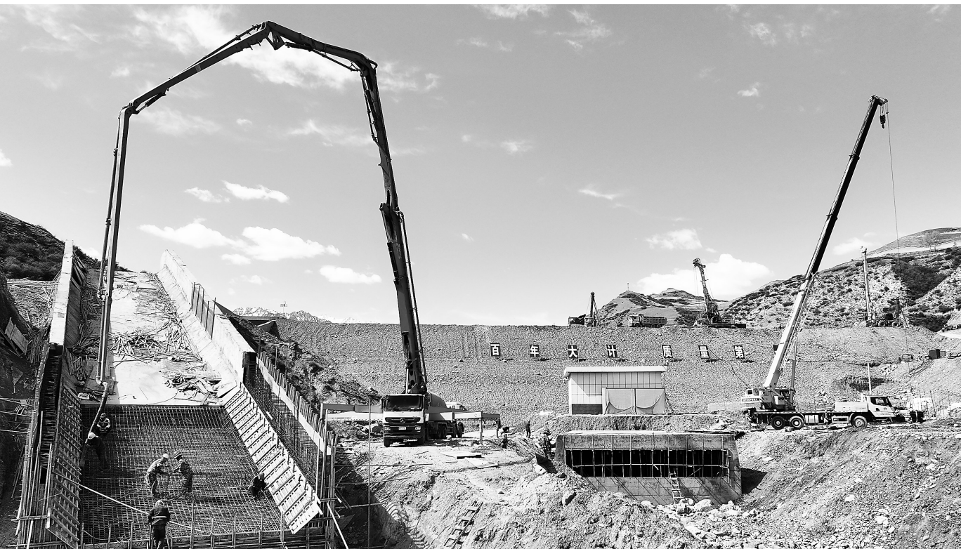
近日,在民乐县小堵麻水库项目建设现场,工人忙着修砌拦河坝防渗墙、溢洪道和泄洪廊道。 新甘肃·甘肃日报通讯员 王晓廷
