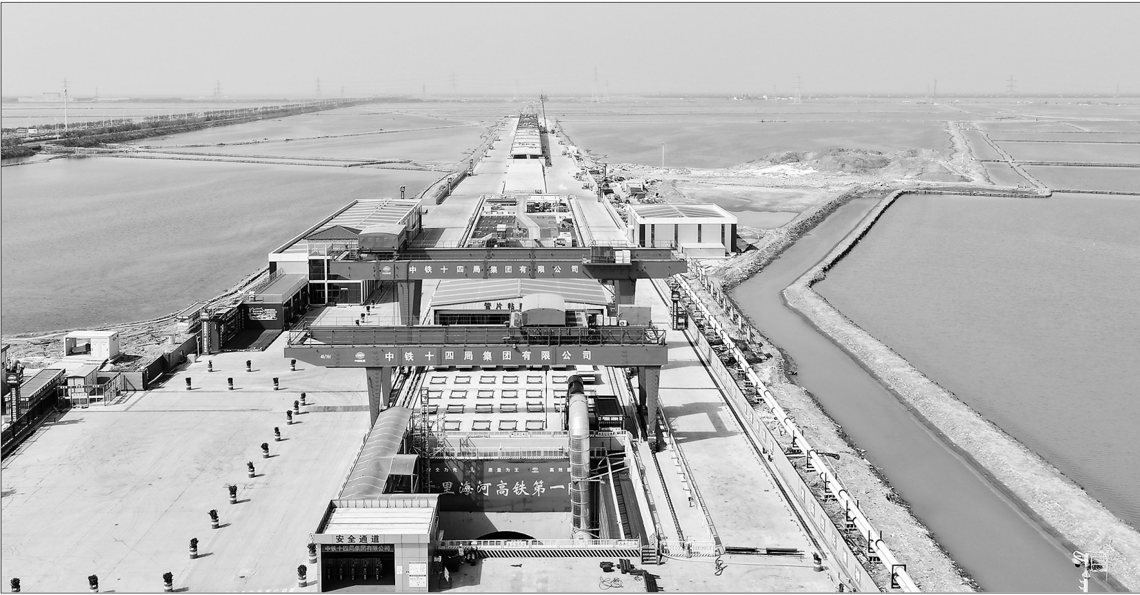
5月19日,由雄安高速铁路有限公司建设、中铁十四局承建的津潍高铁津沽海河隧道超大直径盾构机“津城一号”顺利穿越海河。津潍高铁是我国“八纵八横”高铁网的重要组成部分,起自天津枢纽滨海站,终至济南高铁潍坊北站。图为津潍高铁津沽海河隧道盾构工区。 新华社发
