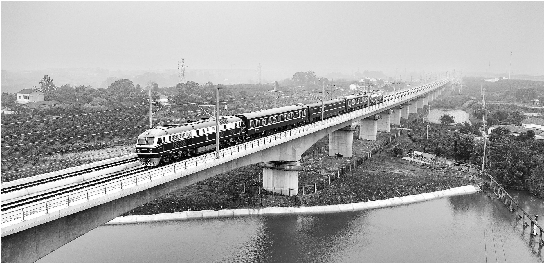
5月15日,55103次检测列车在对沪渝蓉高铁武宜段进行综合测试(无人机照片)。沪渝蓉高铁武宜段位于湖北省境内,起自武汉市,经天门市、荆门市,终至宜昌市,正线全长313公里,设计时速350公里。沪渝蓉高铁武宜段建成通车后,武汉至宜昌的旅行时间,将从目前的2小时缩短至1小时左右。
