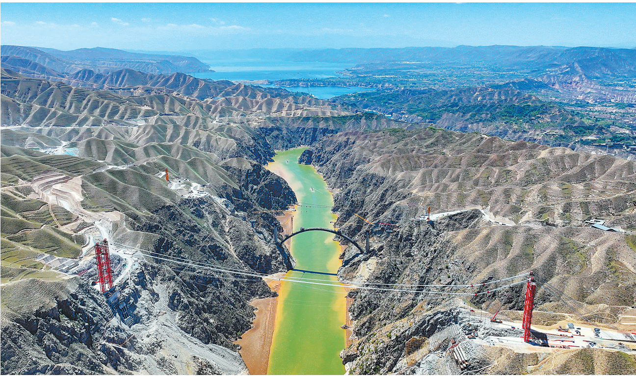
近日，由中铁二十局承建的兰永临高速公路关键控制性工程洮河大桥建设取得突破。该桥500吨大型缆索吊装系统试吊成功，为大桥主体施工按下“加速键”。
