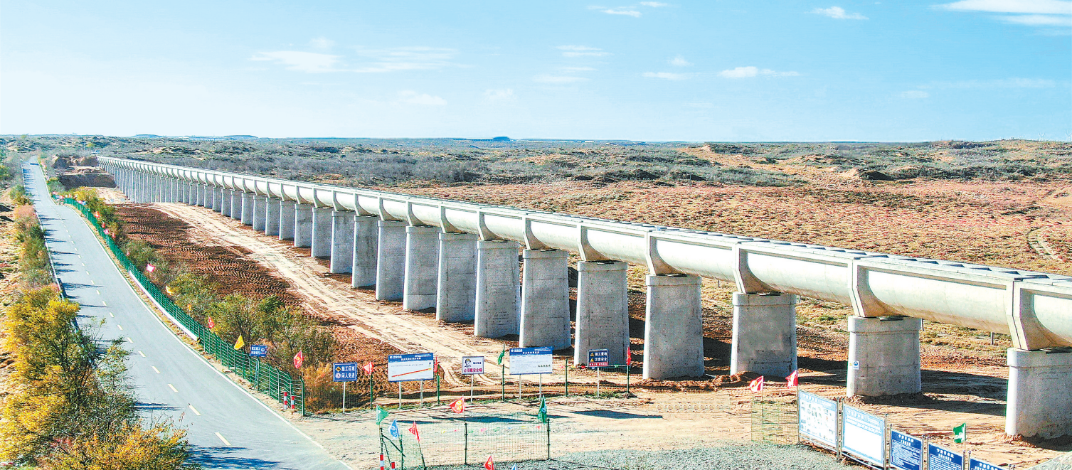
景电二期提质增效工程用来提升黄河水的明渠。
