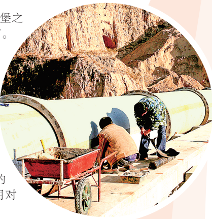
扬黄甘肃专用工程建设中,工人在给管道加防膨胀垫层。
