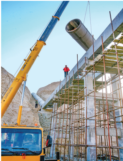
扬黄甘肃专用工程建设中,起重机在架设管道。
