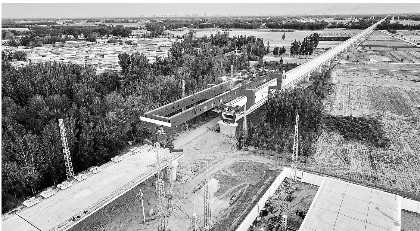
4月27日,中铁二十局集团工人在雄商高铁河北段最后一孔箱梁架设现场作业。雄商高铁是我国高速铁路网“八纵八横”之京港(台)通道的重要组成部分,正线全长552公里,设计时速350公里。
