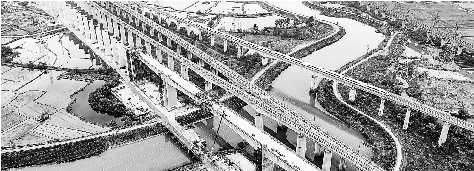
这是中铁四局巢马城际铁路跨清溪河特大桥连续梁施工现场(4月24日摄)。目前,中铁四局巢马城际铁路无砟轨道板铺设、跨清溪河特大桥连续梁等施工稳步推进。巢马城际铁路是国家“八纵八横”高铁网沪汉蓉快速通道合肥至上海间的重要组成部分。 新华社发
