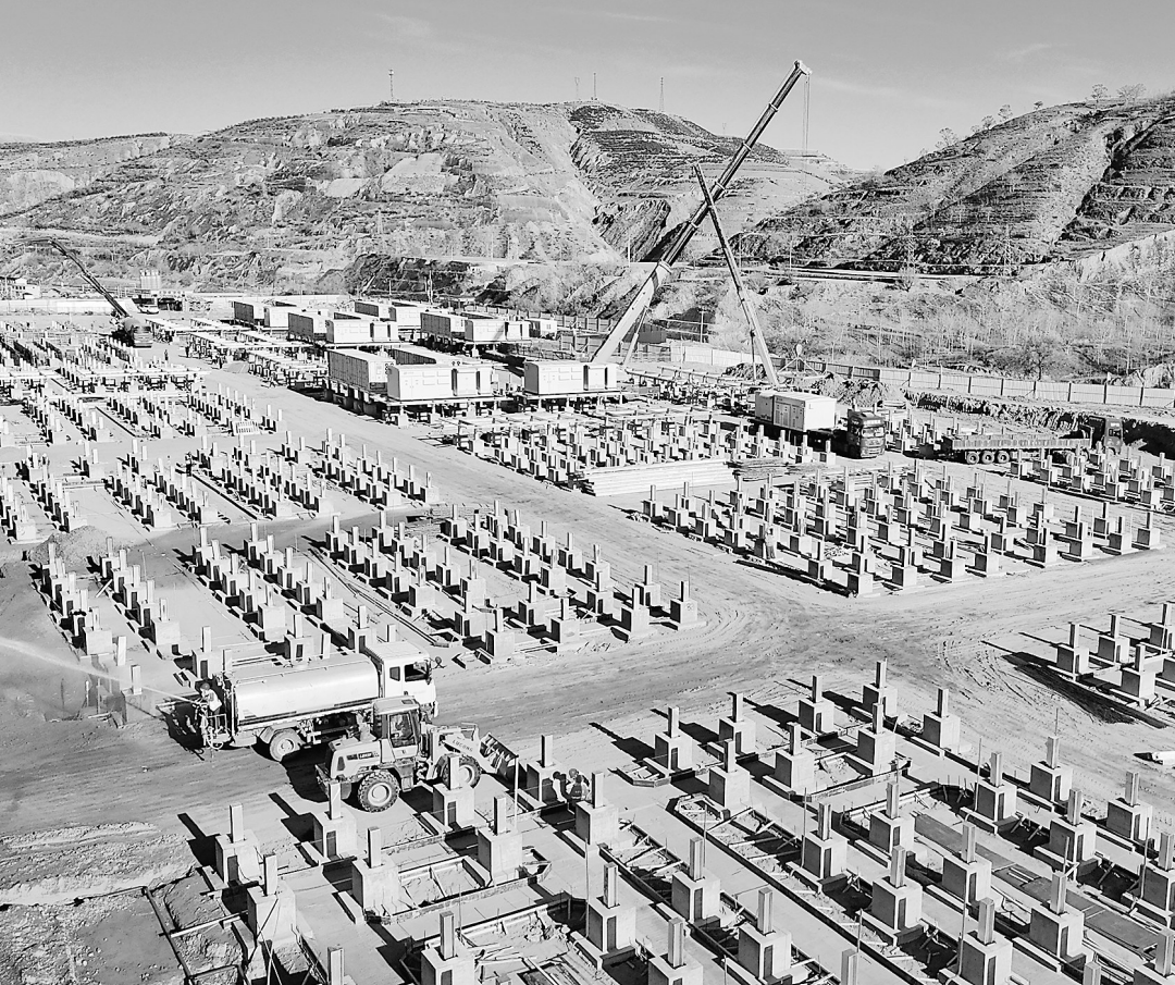
近日,在环县虎洞镇的“陇电入鲁”华能庆阳风光综合新能源示范项目配套F1储能项目建设现场,工人正在安装电池舱。
