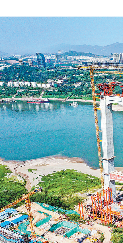
4月19日,黄浦沱长江大桥先导索经交通艇牵引跨越长江,大桥南、北两岸主塔顺利完成“牵手”。这一重要节点的突破,标志着这座世界最大跨径轻轨两用悬索桥正式进入上部结构施工关键阶段,为后续猫道和主缆架设奠定了基础。图为重庆黄浦沱长江大桥先导索架设作业现场。 新华社发
