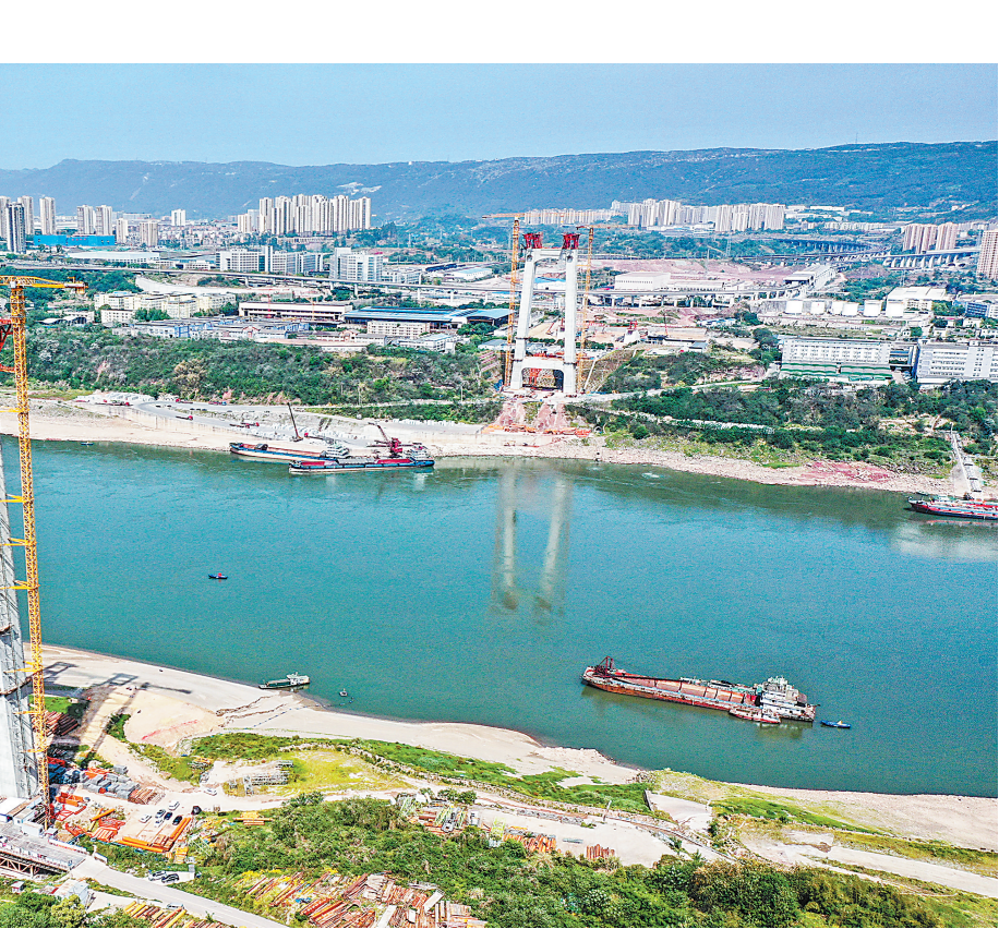
4月19日,黄浦沱长江大桥先导索经交通艇牵引跨越长江,大桥南、北两岸主塔顺利完成“牵手”。这一重要节点的突破,标志着这座世界最大跨径轻轨两用悬索桥正式进入上部结构施工关键阶段,为后续猫道和主缆架设奠定了基础。图为重庆黄浦沱长江大桥先导索架设作业现场。 新华社发
