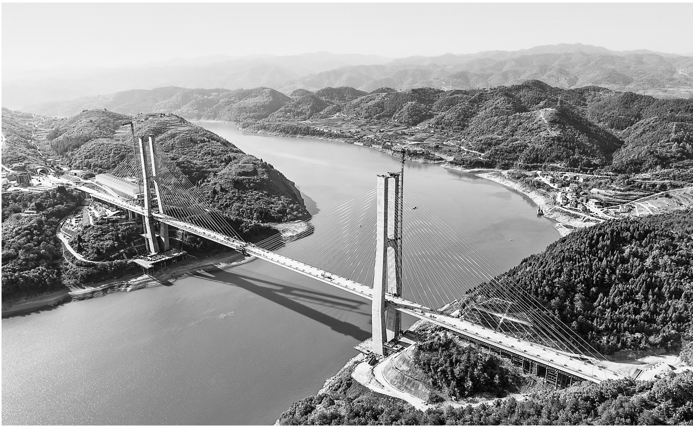
4月14日拍摄的汉江特大桥。当日,由中铁十一局承建的西(安)十(堰)高铁汉江特大桥顺利合龙。汉江特大桥位于湖北省十堰市,全长917.45米,两座主塔高度达186.5米,主跨420米。
