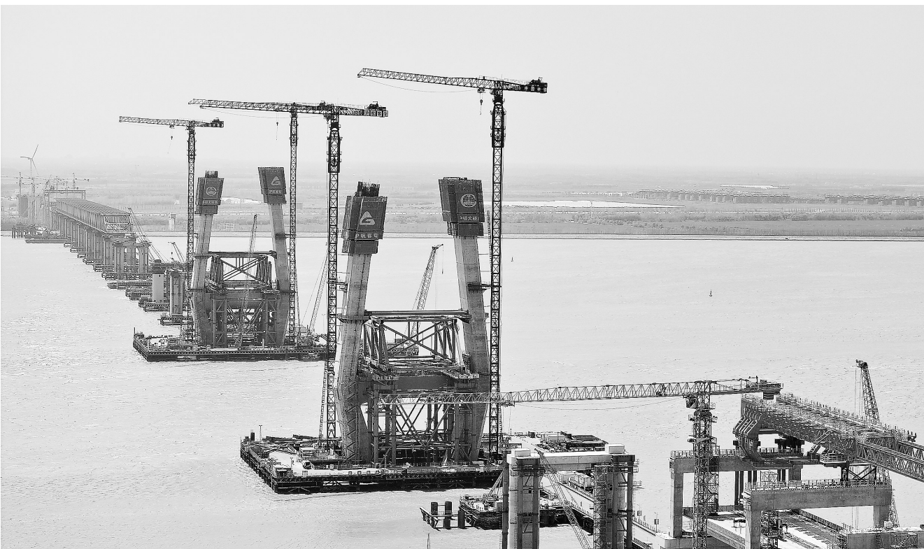
4月13日拍摄的崇启公铁长江大桥4号主塔(中)第17节浇筑施工现场。崇启公铁长江大桥是沪渝蓉高速铁路全线重点控制性工程，大桥全长4.09公里，横跨长江北支，是江苏启东与上海崇明的主要连接通道。
