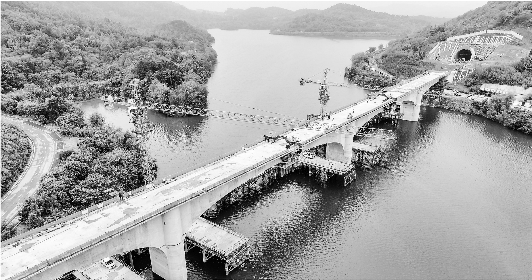
4月12日拍摄的合龙后的成渝中线高铁玄天湖双线大桥。当天，由中铁五局承建的成渝中线高铁全线控制性工程玄天湖双线大桥顺利合龙。成渝中线高铁是我国“八纵八横”高铁网沿江通道的重要组成部分，正线全长292公里，设计时速350公里。
