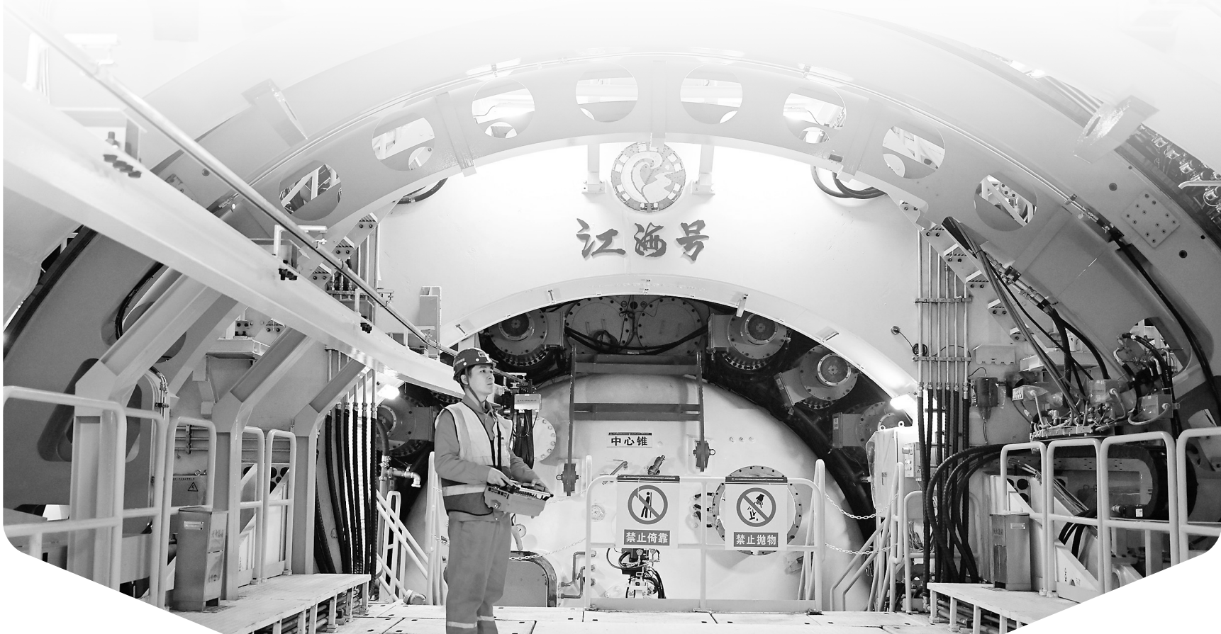
4月9日,中铁十四局工作人员在“江海号”盾构机内进行管片拼装作业。
