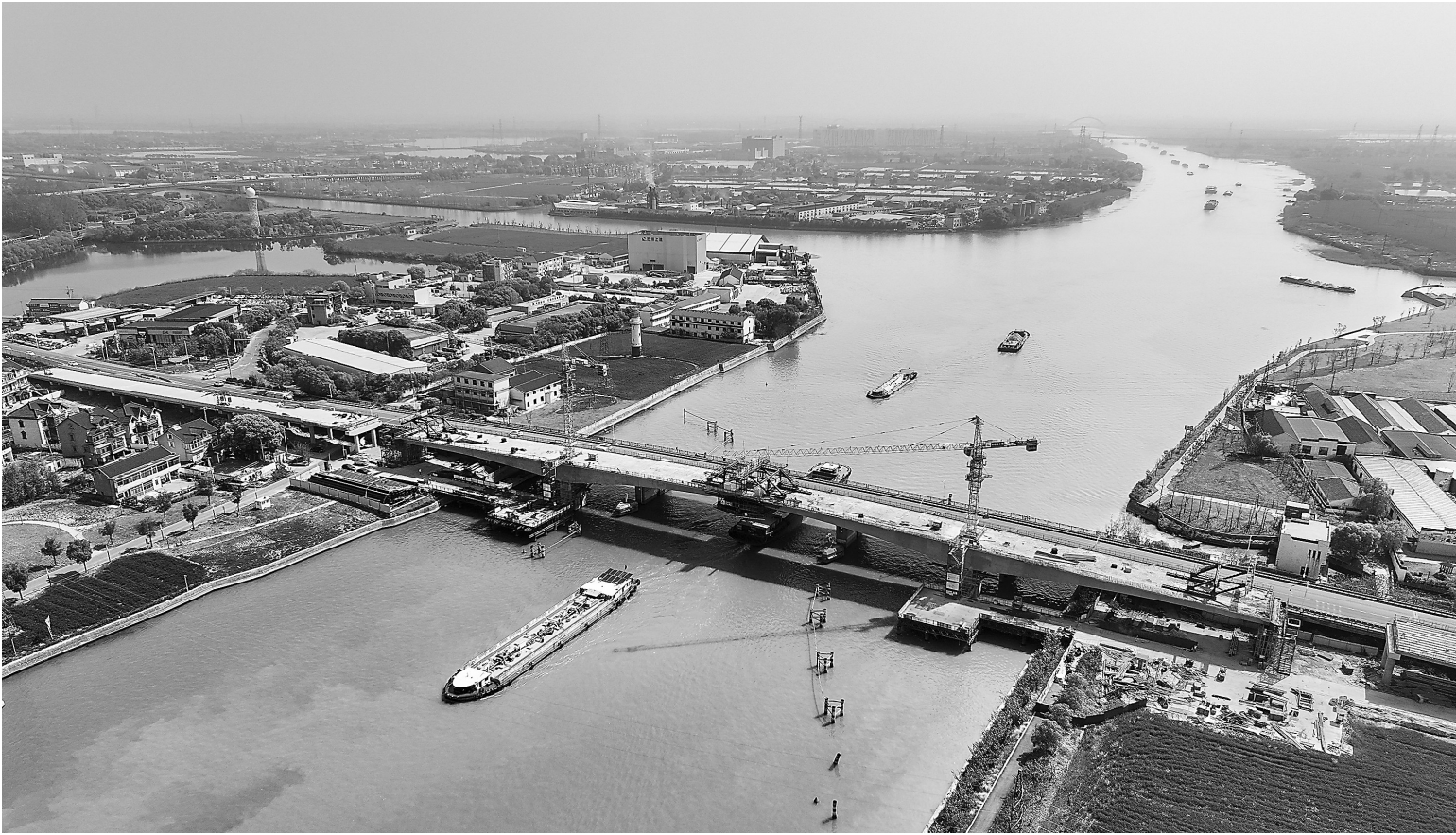
4月8日，船只通过长湖中线(江苏段)航道整治工程新建平望大桥。当日，由中铁建城通公司承建的长湖中线(江苏段)航道整治工程东段项目迎来重要施工节点，项目完成新建平望大桥左幅悬浇梁中跨合龙段混凝土浇筑，为左幅顺利通车奠定坚实基础。
