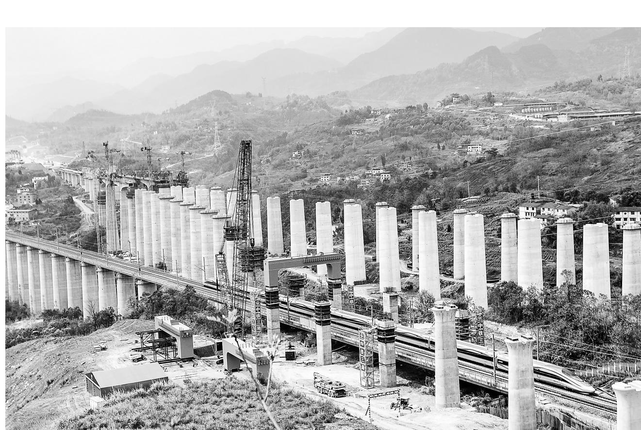
3月27日，在中铁三局承建的成达万高铁左线福寿跨渝万城际特大桥项目施工现场，一榀重达165.8吨的门式墩钢横梁稳稳落在支座上，标志着成达万高铁首个跨既有高铁钢横梁吊装完成。这是当月郑渝高铁线上一列动车从门式墩钢横梁下通过。
