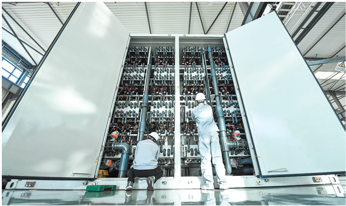
全钒液流电池储能装备就像一个巨型“充电宝”。
