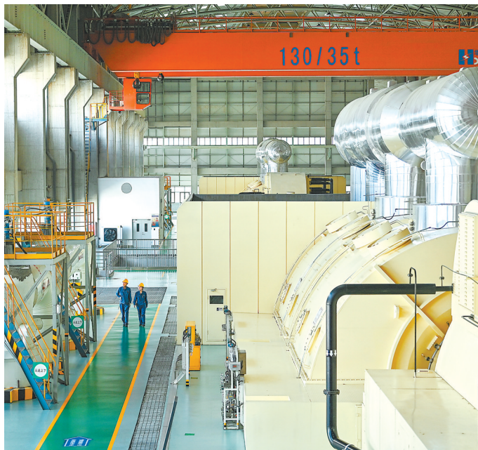
工人检查汽轮发电机组运行情况。
