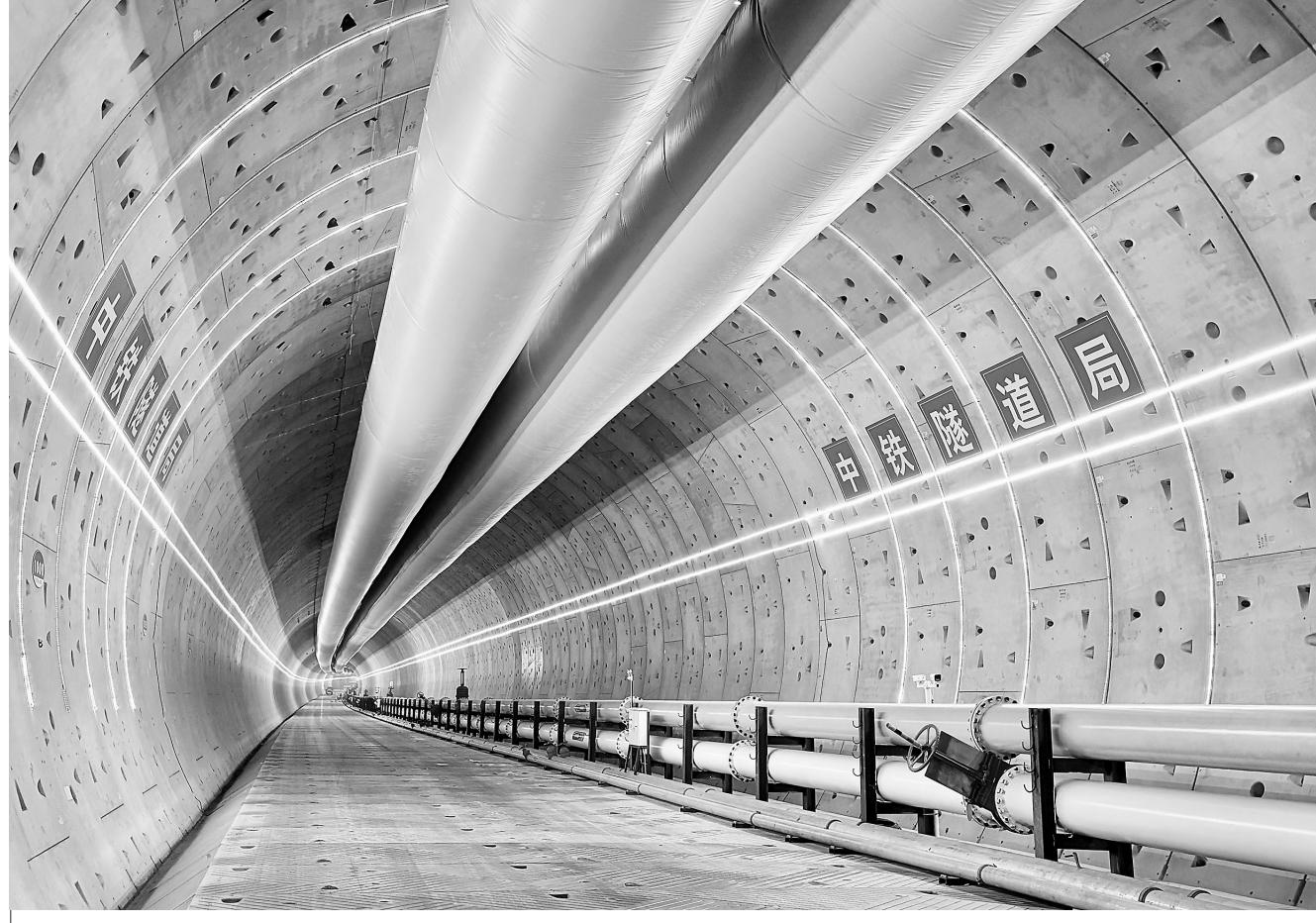
3月16日，沪渝蓉高铁崇太长江隧道掘进突破5000米，距离江心仅剩660米。崇太长江隧道采用“领航号”盾构机掘进施工，盾构机刀盘直径15.4米，搭载智能掘进、智能拼装、超前地质预报等创新技术，以“有人值守、无人操作”的方式，由上海崇明向江苏太仓独头掘进，是目前世界最大直径高铁盾构机。
