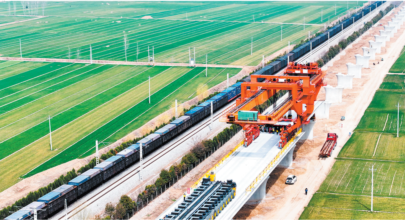
3月13日,在雄商高铁山东郓城县潘渡段,中铁十局的工作人员在进行架梁作业。据悉,雄商高铁是我国高速铁路网“八纵八横”之京港(台)通道的重要组成部分,设计时速350公里。 新华社记者 郭绪雷
