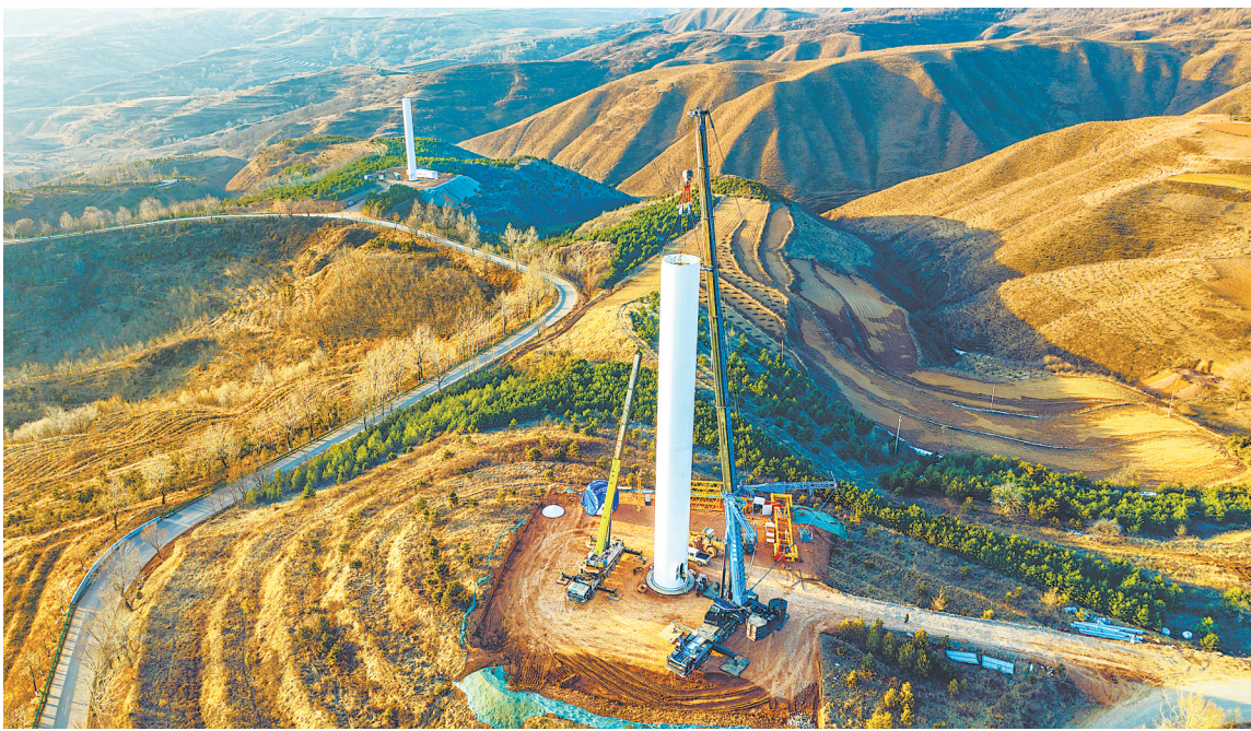
近日,平凉市崆峒区10万千瓦风电项目建设工地,工人正在吊装风机塔筒。该项目拟安装20台单机容量为5兆瓦的风电机组,配套新建一座110KV风电升压站,总投资5.4亿元。 新甘肃·甘肃日报通讯员 黄蔚林
