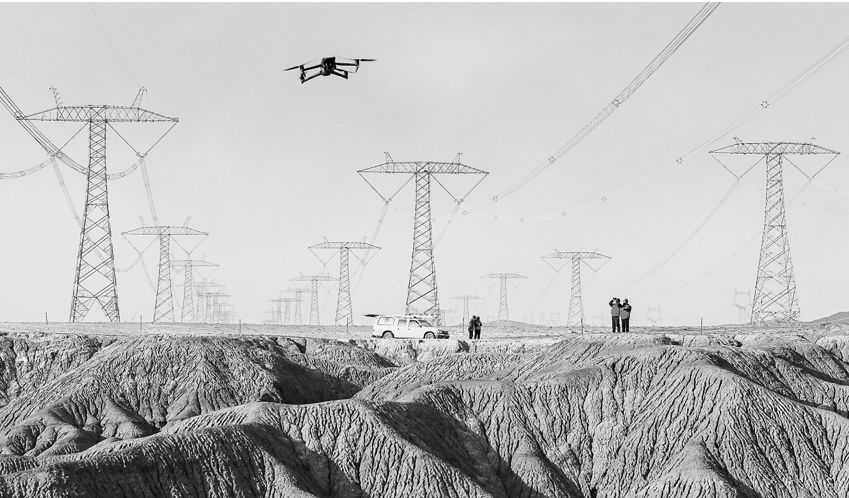
近日,在张掖市甘州区北部山区,国网张掖供电公司工作人员正利用无人机对多条800千伏特高压输电线路开展巡检作业。
