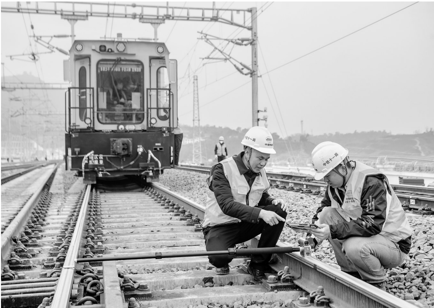
2月18日,在重庆东站建设施工现场,铁路工人在对线路进行精调作业。重庆东站建成后将成为我国西部地区最大的高铁枢纽站,助力成渝双城经济圈及西部陆海新通道建设。
