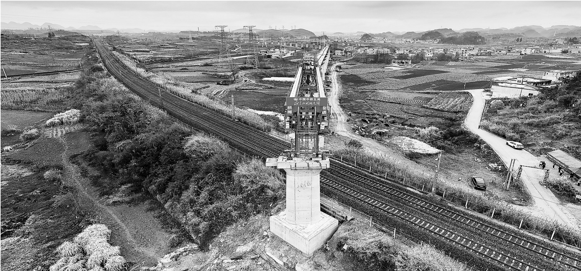
这是2月13日拍摄的T梁架设现场。新建沪昆铁路至安六铁路客车联络线成功上跨既有沪昆铁路，工程建设取得进展，为项目早日建成通车奠定基础。
