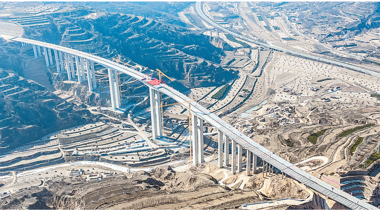
1月19日,位于庆阳市的西合公路项目瓦岗川特大桥合龙。瓦岗川特大桥是G309线西合公路项目控制性工程之一,桥梁总长1304米,宽25.5米。 新甘肃·甘肃日报通讯员 陈飞
