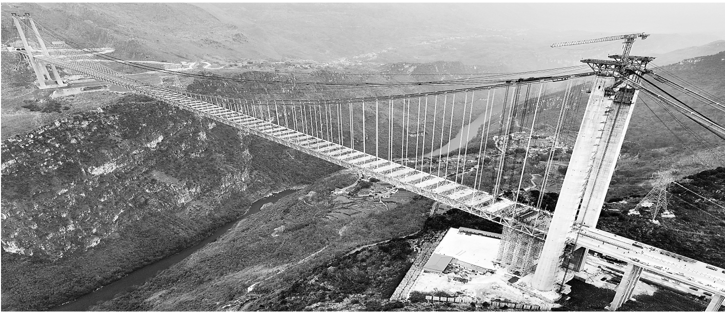
1月17日,在建世界第一高桥——贵州六安高速公路花江峡谷大桥成功合龙,为今年通车运营打下坚实基础。该大桥为钢桁梁悬索桥,全长2890米,桥面至水面高度625米。 新华社发
