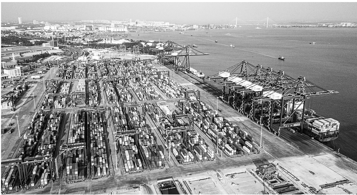
1月11日在海南洋浦经济开发区拍摄的洋浦国际集装箱码头。2024年，洋浦港集装箱吞吐量持续增长并创新高，首次突破200万标箱，同比增长约9.2%。新华社记者 蒲晓旭
