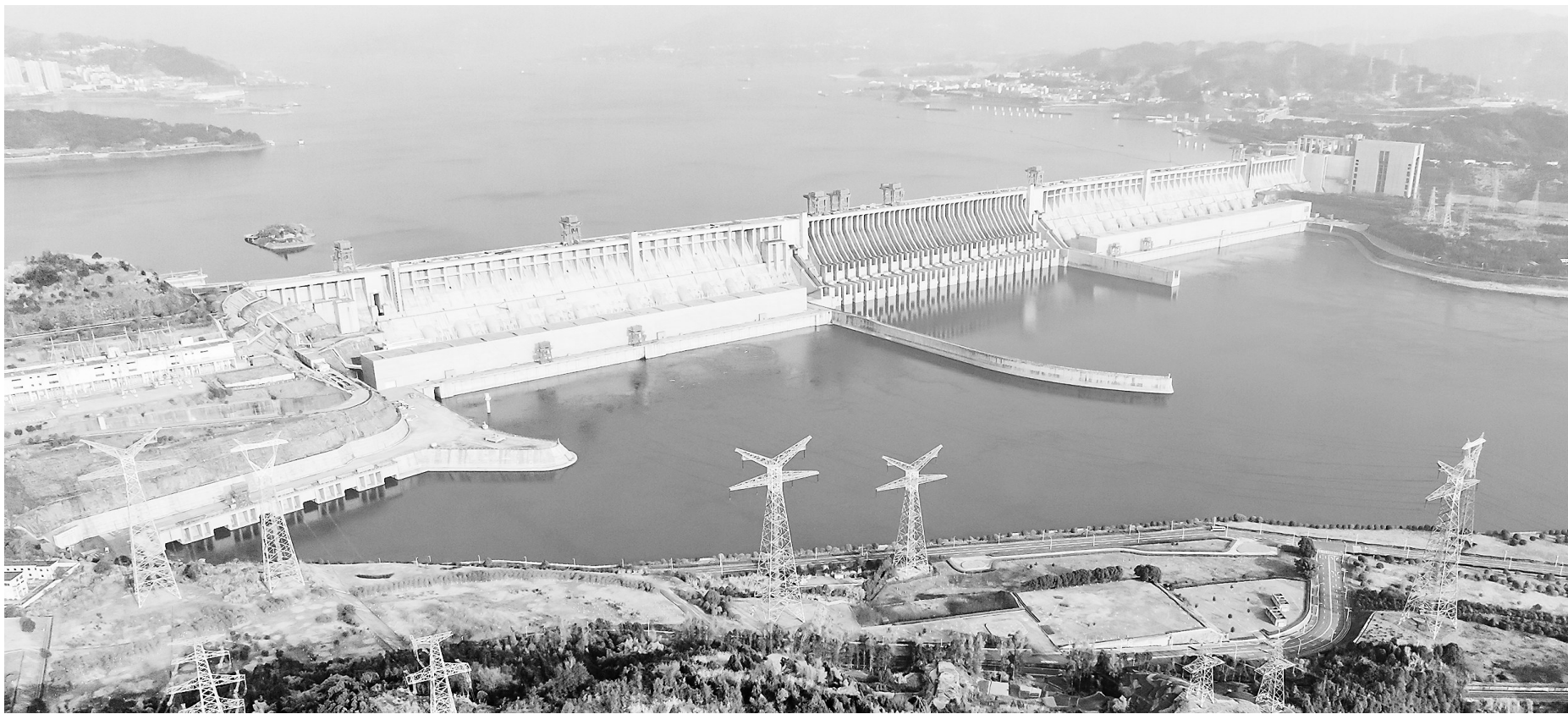
1月10日,在湖北宜昌拍摄的三峡大坝和三峡电站外送输电线路。据三峡集团消息,由长江干流乌东德、白鹤滩、溪洛渡、向家坝、三峡、葛洲坝六座梯级水电站构成的世界最大清洁能源走廊,2024年发电量较上年同期增长超过7%。
