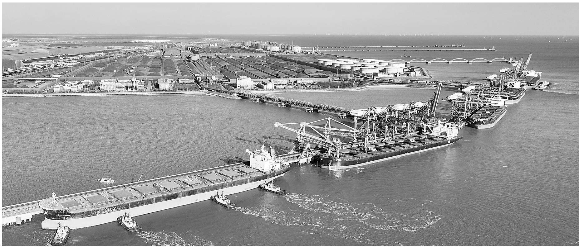
1月9日,轮船靠泊在河北唐山港曹妃甸港区矿石码头卸载。该港口2024年货物吞吐量达14.05亿吨,同比增长3.2%。
