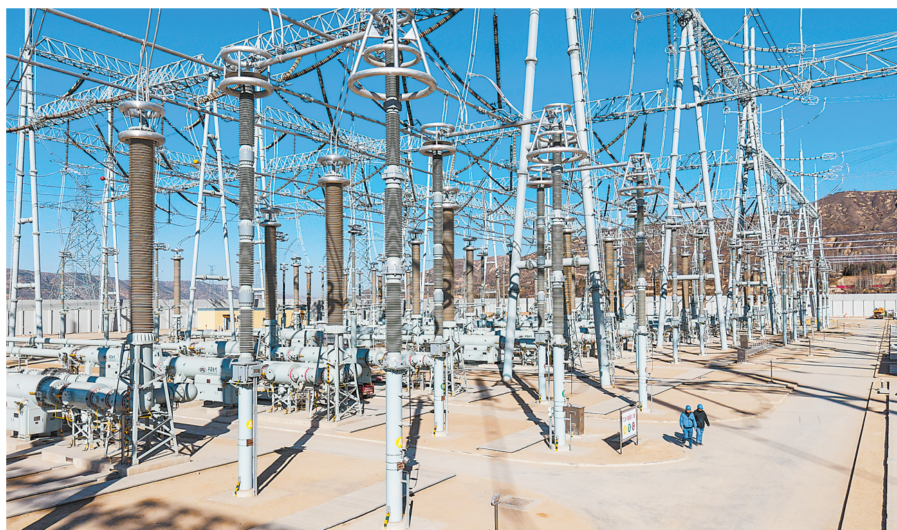
1月7日,在庆阳北750千伏输电工程施工现场,工作人员正在进行投运前的最后准备工作。该工程是“陇电入鲁”重要配套工程。 新华社记者 郎兵兵
