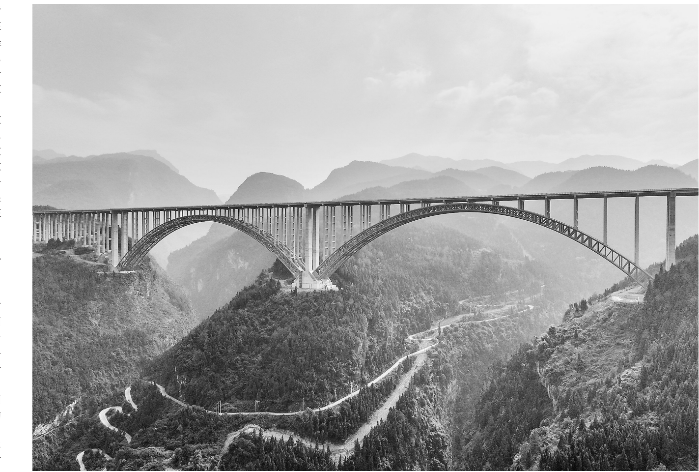
图为渝湘复线高速公路双堡特大桥。1月2日,渝湘复线高速巴南至武隆段、彭水至酉阳段向社会车辆开放通行,重庆东南部武陵山区又添一条高速公路大通道。新华社发
