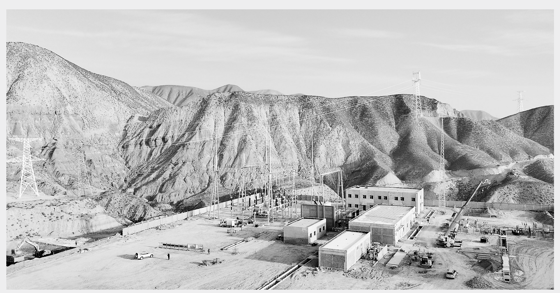
近日，在永靖县“十四五”盐锅峡光伏发电项目建设现场，工人正在进行安装作业。施工单位加快建设进度，确保2025年4月并网发电。 新甘肃·甘肃日报通讯员 侯奇志
