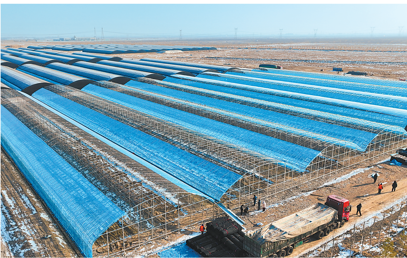
近日,施工人员在张掖市甘州区巴古滩现代农业设施农业项目现场建设日光温室。 新甘肃·甘肃日报通讯员 冯杰
